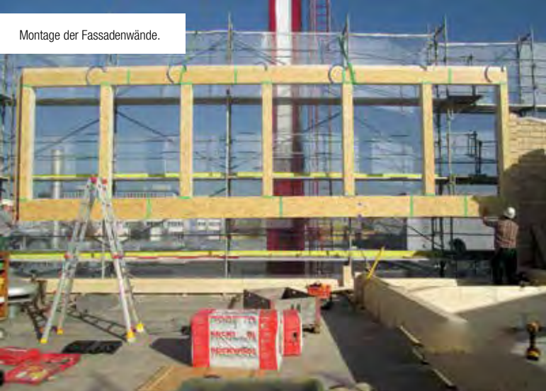
Die Holzelemente passen ganz genau und werden ineinander «verkeilt».
